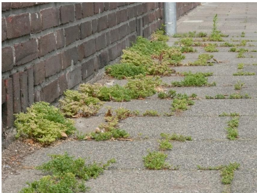
Kransmuur (foto H. Kuiper)
