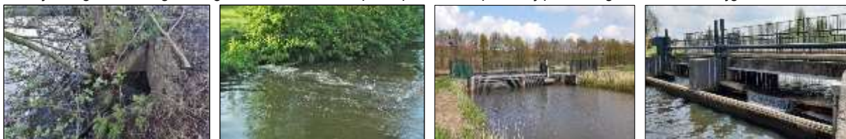
foto 2 ◀◀: klepduiker afwaterend op de Donge foto 3a/b ▶▶: monding Stads-Donge in het Wilhelminakanaal bij aflatwerk/reiniger Dongense Kanaaldijk.
