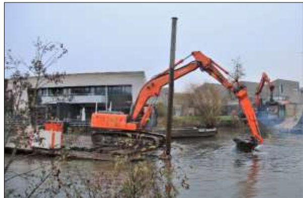
foto 6a/b: In het najaar van 2017 is een groot bagger-project uitgevoerd, waarbij uit een centrale slenk duizenden kuubs modder en zand werden afgevoerd.
