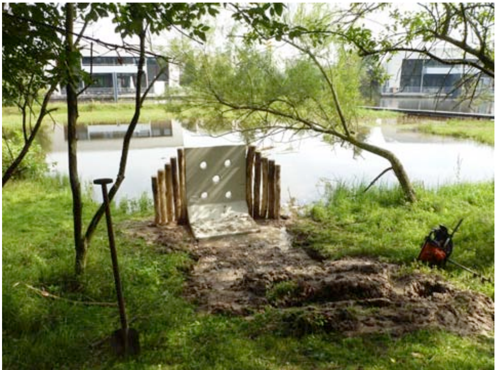
Aanleg ijsvogelwand (foto Guido Stoker)
