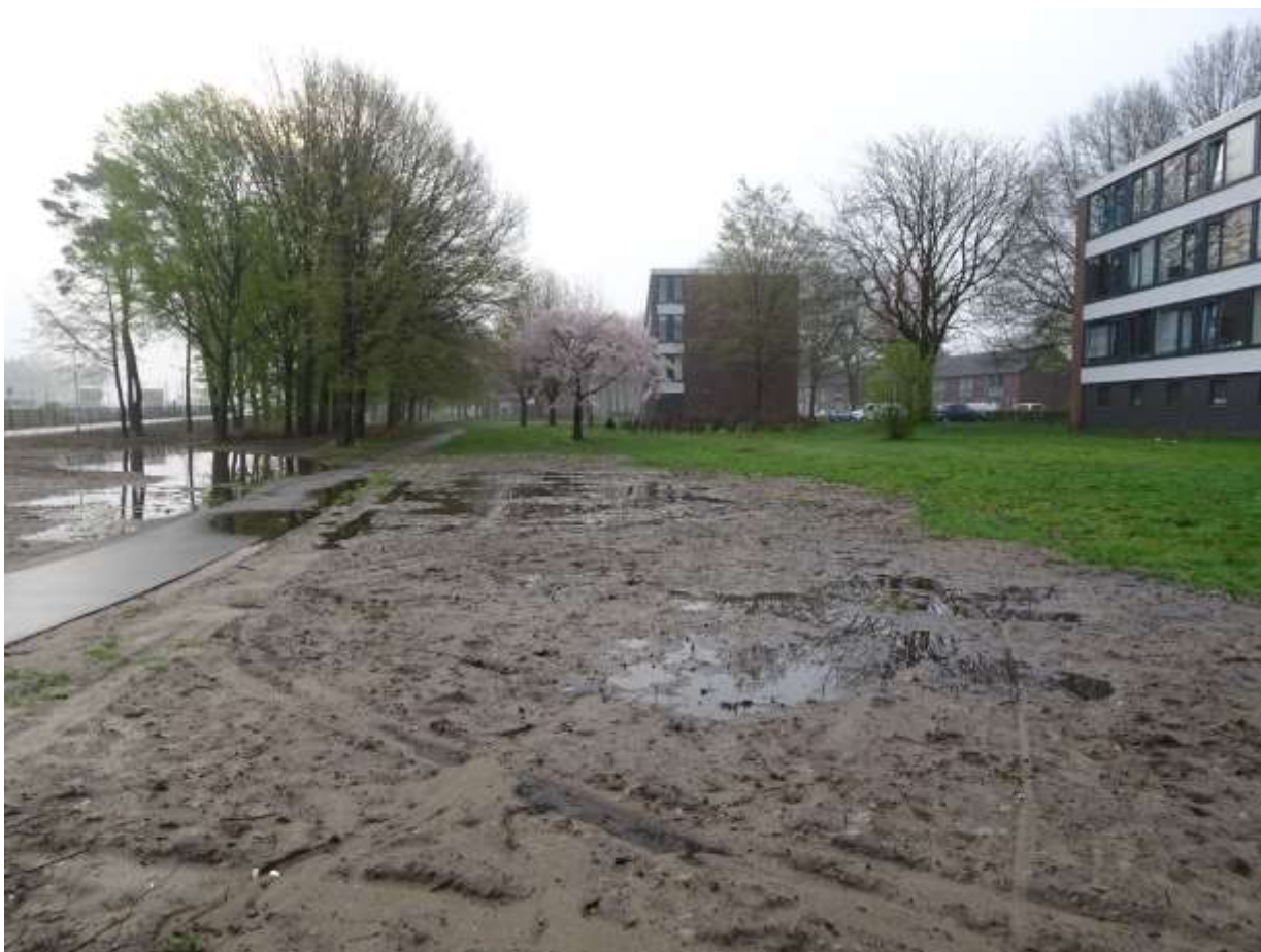
11-04-2018 Berm na de aanleg van sluis III Wilhelminakanaal - O1 Bieslookweg
