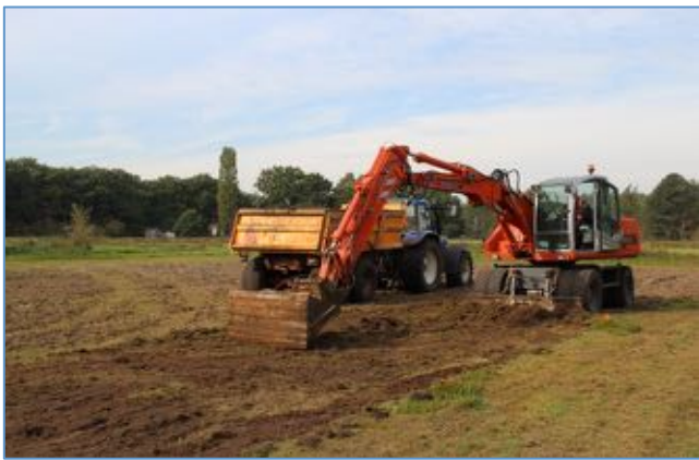
Figuur 8. Bij het chopperen wordt ca. 5cm van de gefreesde wortelzone afgevoerd.
