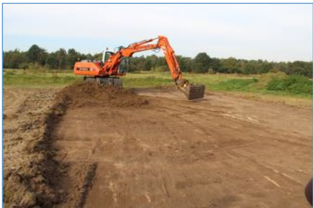
Figuur 10. Bij plagen wordt gehele bewortelde bodemlaag afgevoerd tot op de zandige ondergrond.
